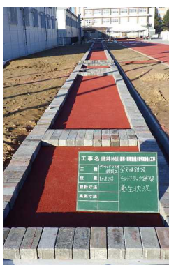
舗装材がきちんと接着するよう に、重石(おもし)を置いて養生 しています
